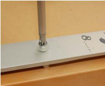
2. Mit einem Bohrer (am besten Ø 4,2 mm) wie gezeigt mit der Hand die Reste des Auflagegummis ausbohren. Evtl. verbleibenden Rest mit Pinzette entfernen.
