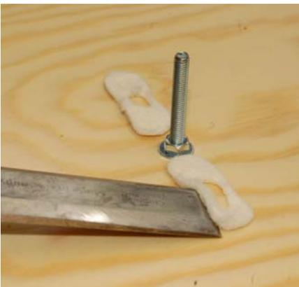
2. Alte Gummiauflage und selbstklebenden Filz entfernen. Filz- und Klebereste vorsichtig entfernen, z. B. mit einem Meißel.
